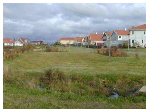
Öppet dagvattendike på Annehem
