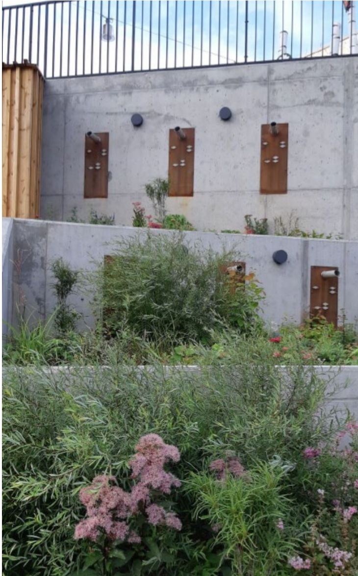
Exempel på regnbäddar placerade i en yta med höjdskillnader.
