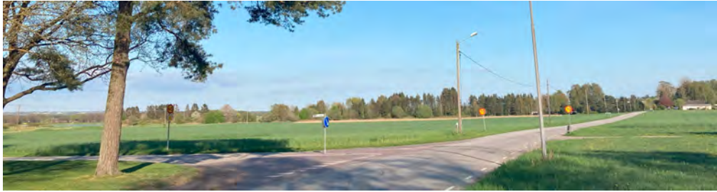
Befintlig situation längs Hällestadsvägen från väster, ut från Södra Sandby.
