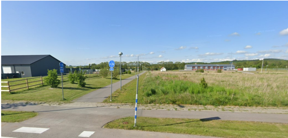
Bild mot norr från övergångsstället över Genvägen. Planområdet med lagerlokal till vänster, cykelvägen mot Höje å i mitten, pumpstation i vit byggnad mitt i bilden och Räddningstjänstens grå byggnad med röda portar i bakgrunden.
