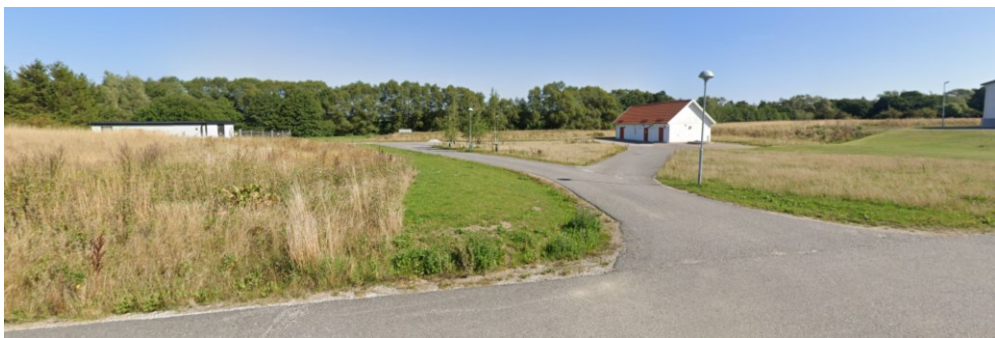
Kopplingsstation för el och pumpstation för spillvatten.
