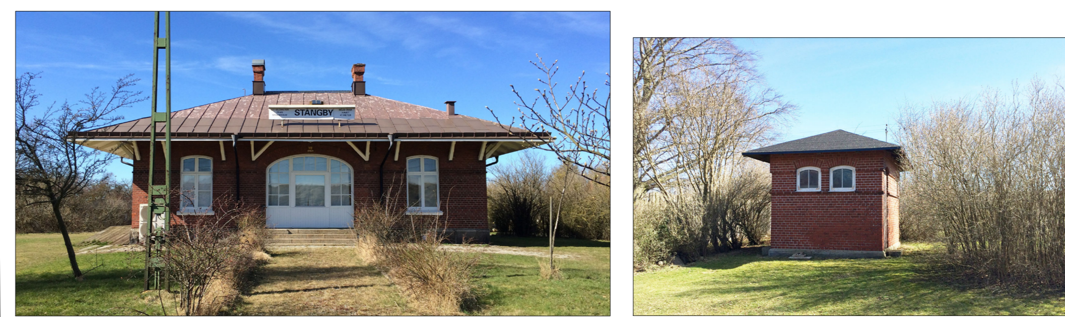
Stationeryggnad: Fasader med sockel av granitblock samt rött hårdbrunt tegel med påfång ska bevaras. Dekorativ utformning vid taklinjen bevaras. Ursprungliga fönster och smidesjärn över- och sidofas till huvudentrén, samt dörröppning till norra huvudentrén bevaras. Murade skorstenar i rött tegel bevaras. Interiör planering med murade väggar och äldre träbänkar bevaras. Fast inredning i form av takstuckar, äldre fönster-, dörr- och sockelbänkar bevaras.
