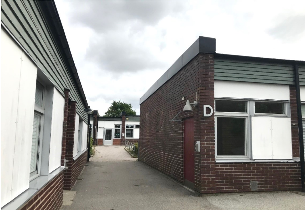
Del av exteriör. Fasader av mörkt tegel, vita fasadskivor och liggande träpanel samt aluminiumfönster. Platta tak och hårdgjorda markytor.
