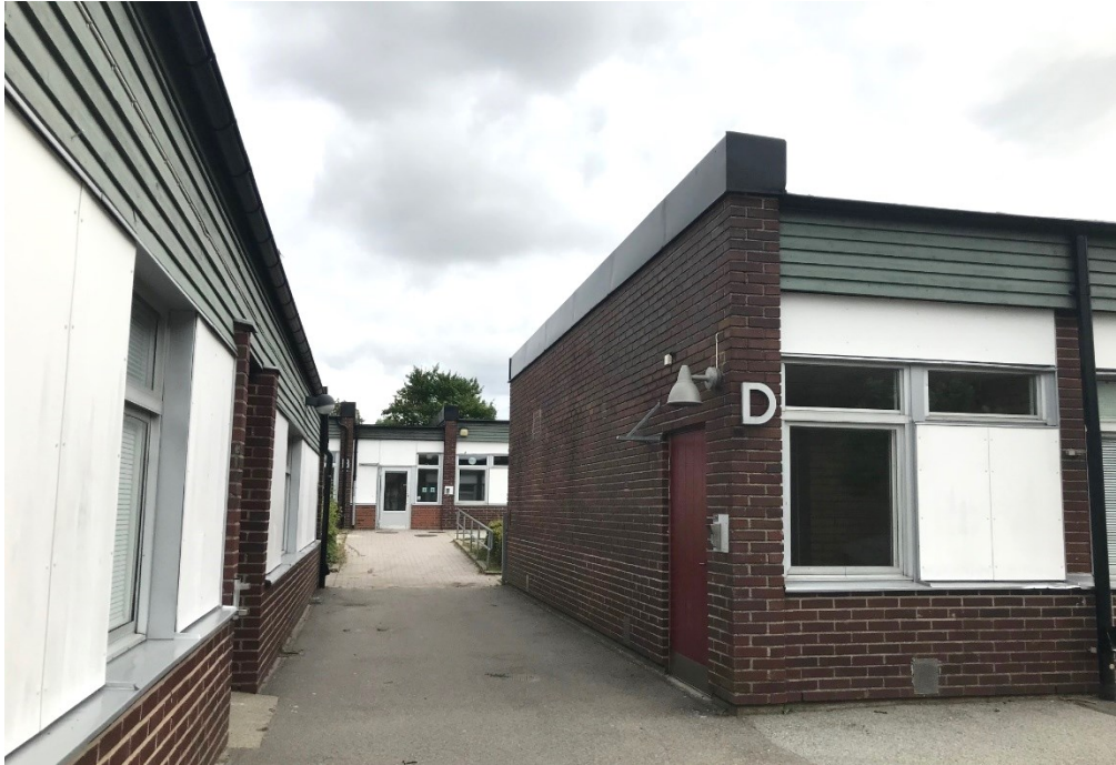
Del av exteriör. Fasader av mörkt tegel, vita fasadskivor och liggande träpanel samt aluminiumfönster. Platta tak och hårdgjorda markytor.
