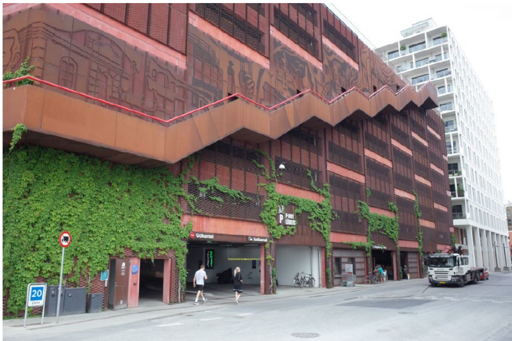
Mobilitetshus i Köpenhamn, med omsorgsfullt gestaltad fasad och levande bottenvåning – som inspiration för gestaltning av mobilitetshus i stadsmiljö.
