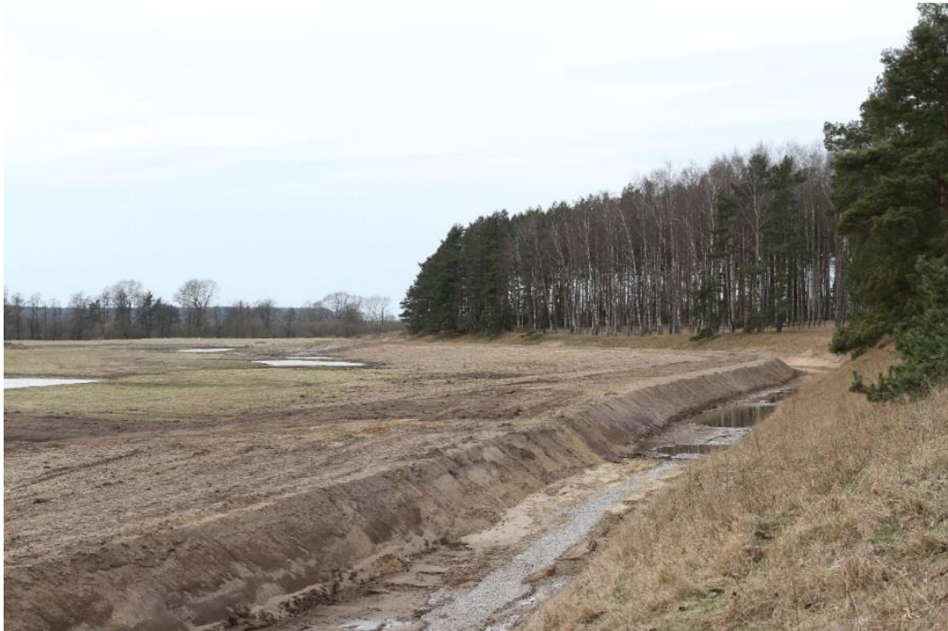
Figur 4-3. Den gamla huvudkanalen för översilningsområdet vid Björka har återställts för att åter kunna leda ut näringsrikt vatten på ängarna. Restaureringen av översilningsområdet har genomförts av Kävlingeåns vattenråd. Bild: Björn Barup.
