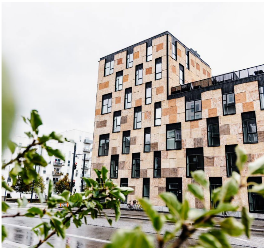
Resource Rows i Köpenhamn. Återbrukat fasadtegel och fönster, återbrukat material har också använts interiört. Bild: NREP
