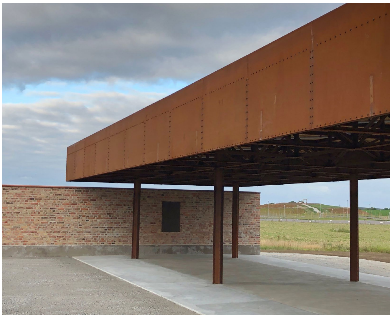
"Hage" på Brunns hög, med återbrukat tegel.
