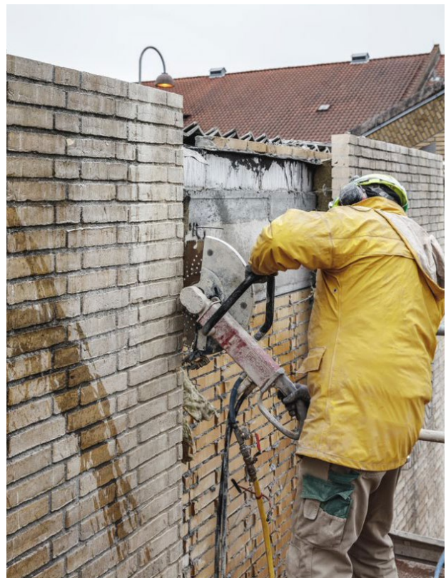
Demontering och återbruk av fasadtegel. Bild: NREP
