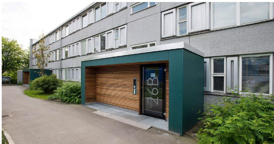
Vikingavägen, LKFs bestånd på Linero som har genomgått omfattande renovering med energiåtgärder. Bild: LKF
