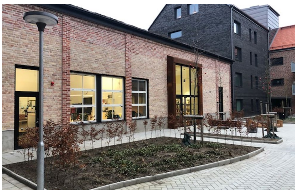
Kryptan i S Sandby. Bevarande och upprustning av industribyggnad till bibliotek.
