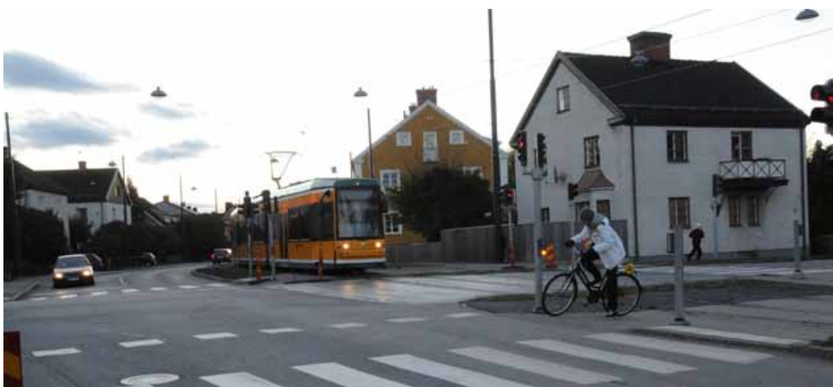
Figur 3-8. Ett stycke sidoförlagd spårväg i Norrköping. Vid korsningar är det särskilt viktigt att tydliggöra trafiksituationen, då både spårväg och gata har trafik i båda riktningarna. För oskyddade trafikanter bör det finnas ett skyddsutrymme, så att passage kan ske i etapper.
