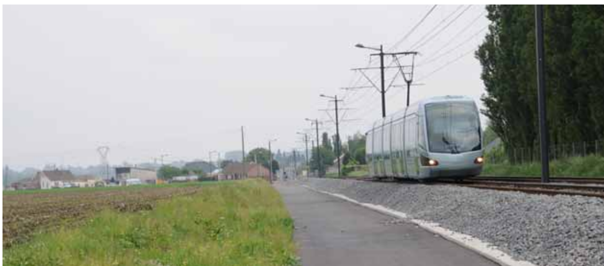
Figur 3-15. På landsbygdssträckor blir spårvägen vanligen mer järnvägsläk. Här på makadambädd utanför Valenciennes, Frankrike.
