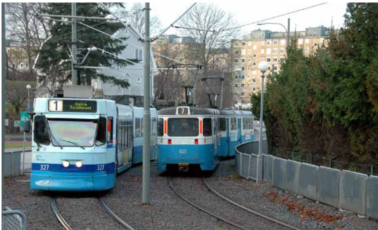
Figur 2-2. Snabbspår i Göteborg. Banan, som ligger på makadambädd, avgränsas från omgivningen med nätstaket. Även kontaktledningsanläggningen är mer järnvägmässig än motsvarigheten i Lyon.
