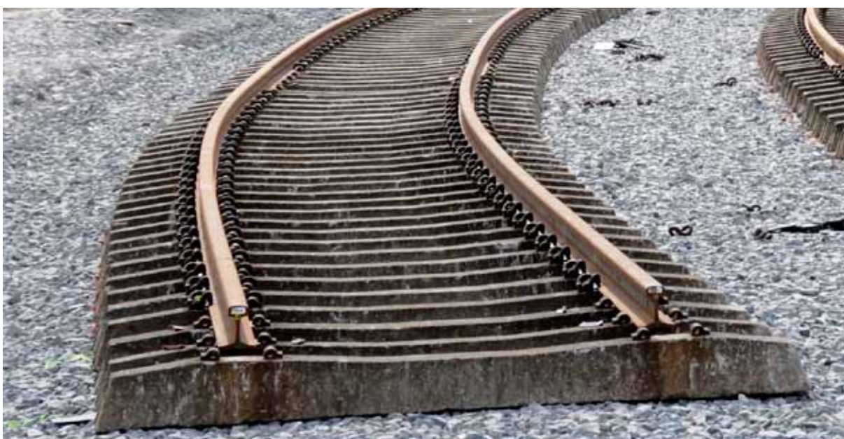
Figur 3-14. Vignolräler i ett spår under byggnation i Norrköping.
