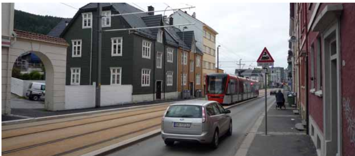
Figur 3-10. I Bergen används på många ställen en materialblandning baserad på majs för att färgmässigt särskilja spårområdet (för övrigt är korsningar med biltrafik rödfärgade och korsningar med gångtrafik är grå). Dessutom används en nivåskillnad för att förtydliga trafiksepareringen.
