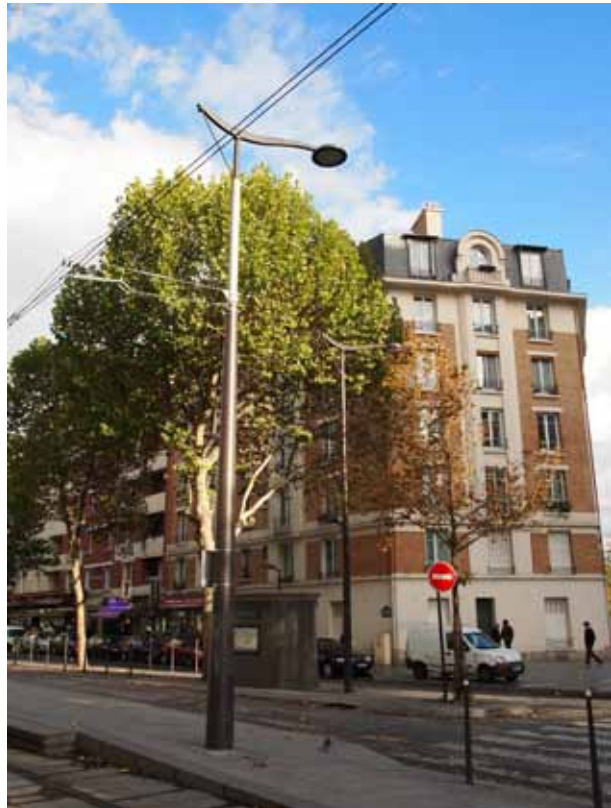
Figur 3-18. Exempel från Paris där kontaktledningsanläggningen samordnas med gatubelysningen.
