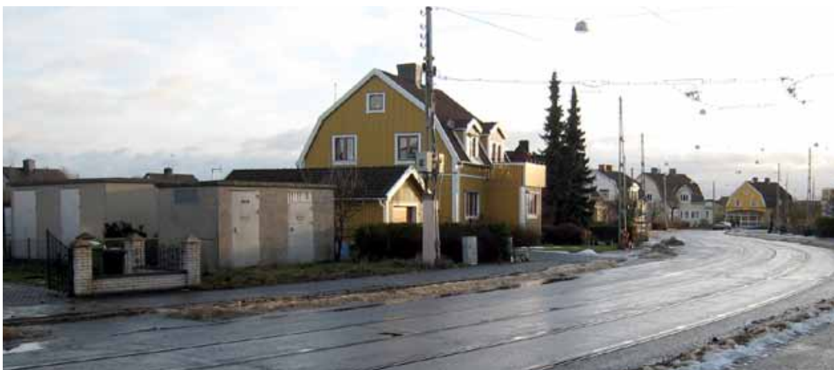
Figur 3-22. Likriktarstation i Norrköping (till vänster) – storlek ca 25 kvadratmeter. Endast en av byggnaderna är till för spårvägen, den andra är nätstation för eldistribution till det aktuella området i Norrköping.
