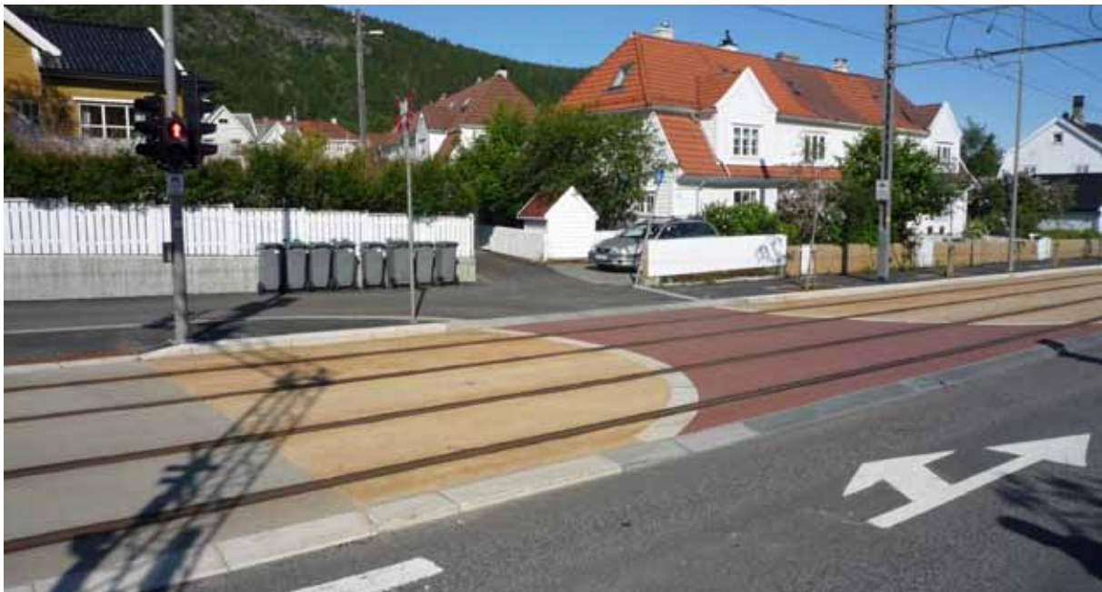
Figur 4-6. På Bybanen i Bergen används samma färgmarkeringar utmed hela banan. Korsningar med biltrafik är rödmarkerade och korsningar med gångtrafik är grå. En entydig, förutsägbar och återkommande trafiksituation minskar risken för olyckor.
