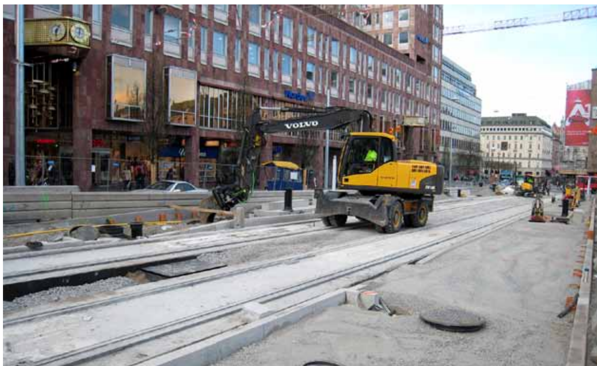
Figur 3-25. Spår lagt i prefabricerade betongelement med gummiinlägg minskar både vibrationer och buller. Här från byggnationen av Spårväg City i Stockholm.
