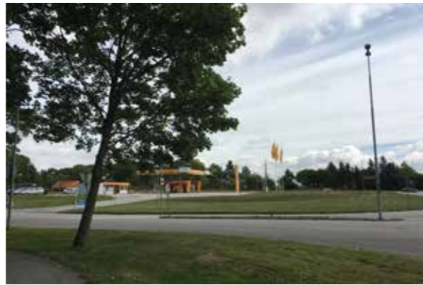
Bensinstationen sedd från väster.
